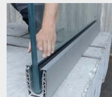
Pose des joints
