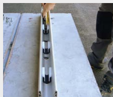
Positionnement des cales
