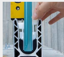
Serrage des cales et réglage de la verticalité
